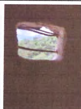
MANTENIMIENTO DE BALCONES, SUSTITUCION DE BALCONES DE VARILLA RETORCIDA
