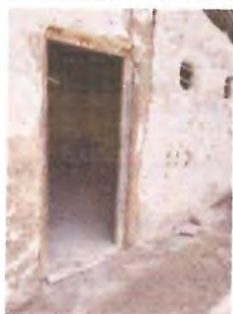
REPARACION DE MUROS, EN MAL ESTADO
