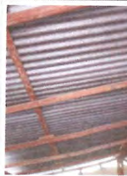
ESTRUCTURA DE TECHO, SUSTITUCION DE ESTRUCTURA DE TECHO DE MADERA EN MAL ESTADO
